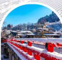
สะพานนากะบาชิ
