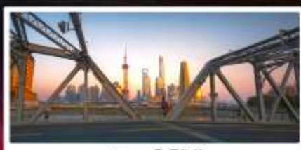
สะพานไวปู้ตู่
